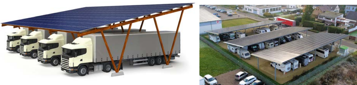
Abb. 20: Ansicht PV-Stellplatzüberdachung für Lkws, die eine große Bauhöhe erreicht (Fotos: 4th Life Photography über Adobe Stock (links), Carpor GmbH (rechts))
