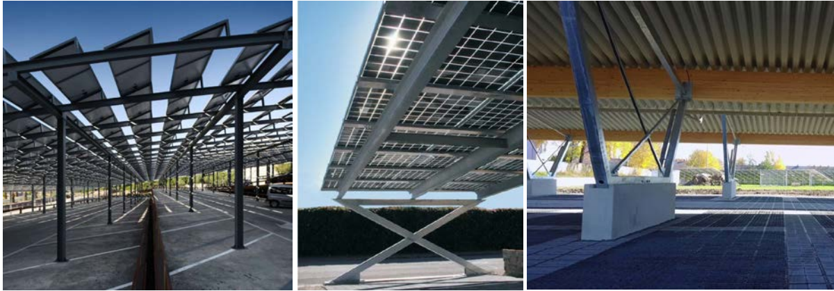
Abb. 18 PV-Parkplatzüberbauung ohne Dachfunktion, Universität in Murcia (Links, Foto: ecoprojecta.es), PV-Stellplatzüberdachung, Dachfunktion durch PV-Module (Mitte, Foto: ClickCon), PV-Stellplatzüberdachung, Dachfunktion durch Blechdach (Rechts, Foto: PMT)
