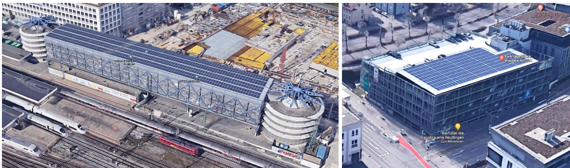
Abb. 7: Überdachtes Parkhaus mit PV-Anlage in Mannheim (links) und teilüberdachtes Parkdeck auf Parkhaus in Reutlingen PV-Anlage in Reutlingen (rechts) (Bild: Google maps)
