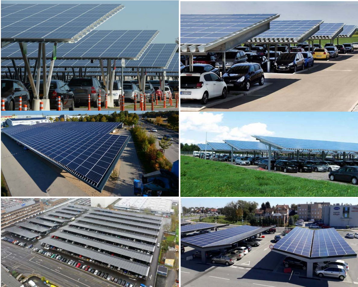
Abb. 19: Beispiele für PV-Stellplatzüberdachungen: Flughafen Weeze (Oben links, Foto: Gottfried Evers), Firmenparkplatz in Ilshofen (Oben rechts, Foto: Carpor), Park&Ride-Parkplatz Bamberg (Mitte links, Foto: Münch), Firmenparkplatz (Mitte rechts, Foto: Hörmann), Firmenparkplatz ZF in Schweinfurt (Unten links, Foto: PMT), Parkplatzüberdachung Supermarkt Zagreb (Unten rechts, Foto: SENS)
