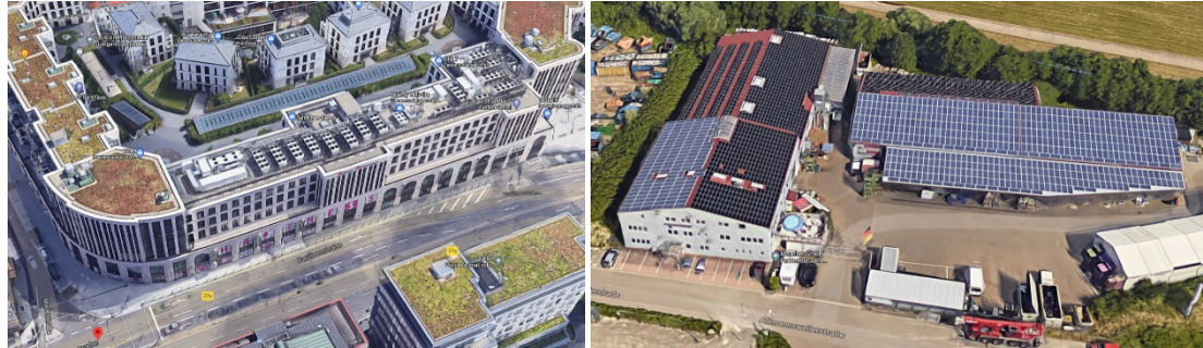
Abb. 9: Dachaufsichten von NWG mit einem hohen Anteil an nicht solargeeigneten Flächen (links: der Längsbau ist fast vollständig mit Technikaufbauten belegt, Beispiel aus der Innenstadt Stuttgart) und NWG-Dachflächen, die fast vollständig mit PV-Modulen belegt sind (rechts Beispiel aus Friedrichshafen) (Bilder: Google Maps)
